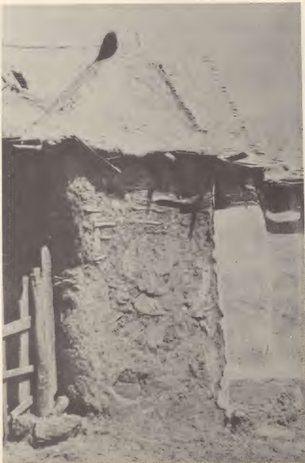
Uitgebouwde stookplaats van een leemwoning te Miralamar
